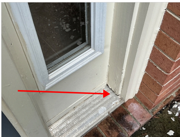
Exterior Door Frame
