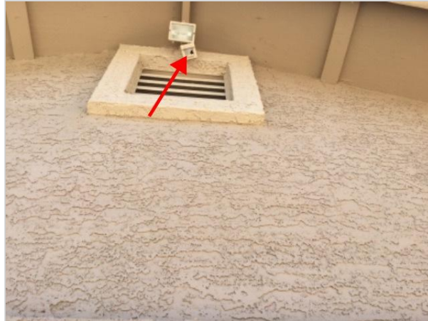
Above Garage Door
