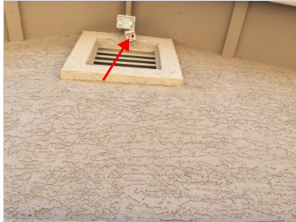
Above Garage Door
